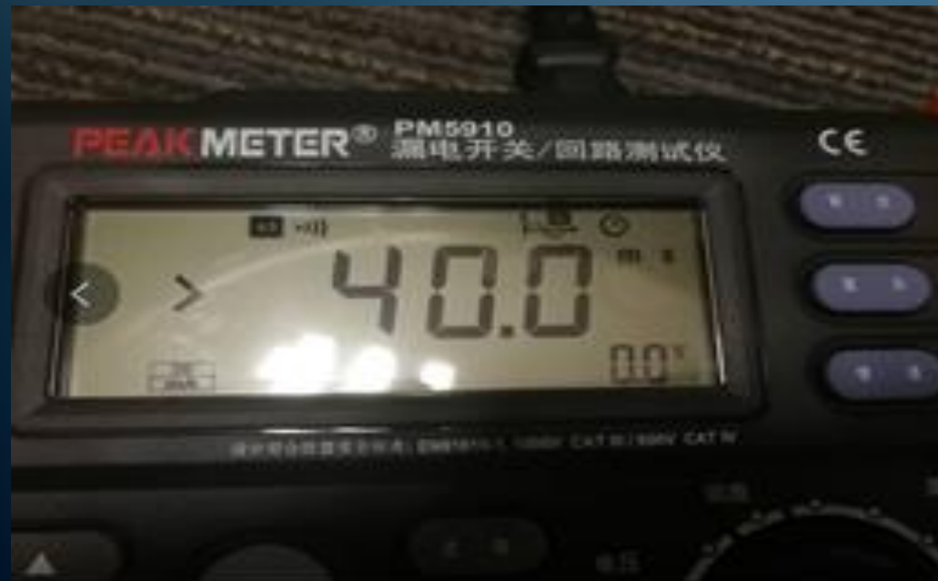
漏电开关失效
